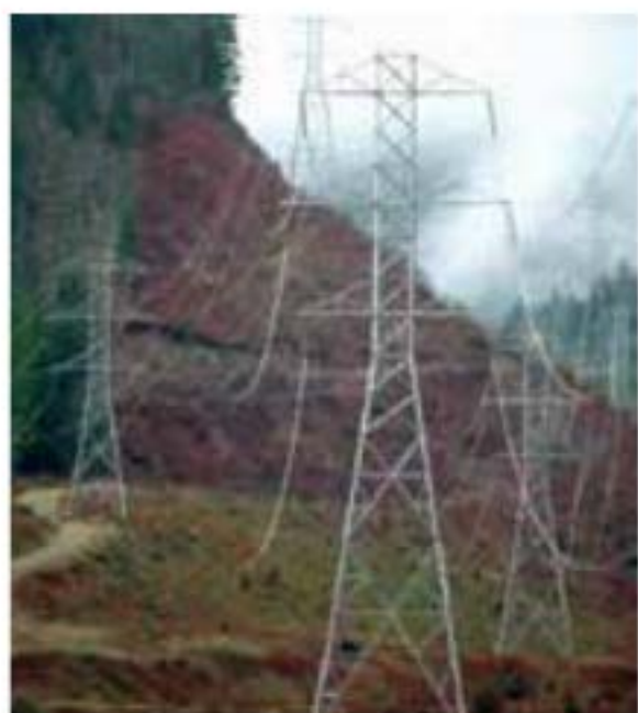
Опори ліній електропередачі
