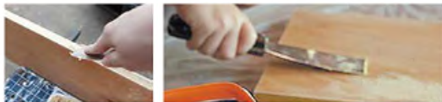
Мал. 142. Процес шпаклювання
