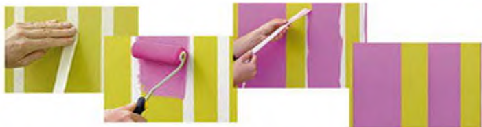
Мал. 222. Технологія фарбування стін смугами
