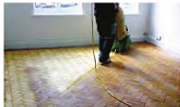
Мал. 86. Прийом циклювання паркету електричною циклювальною машиною
