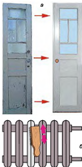
Мал. 232. Фарбування дверей (а) та металевих конструкцій (б)
