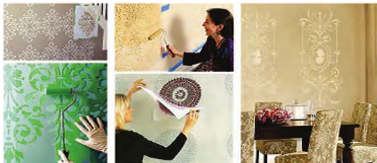
Мал. 228. Нанесення малюнка за допомогою трафарету
