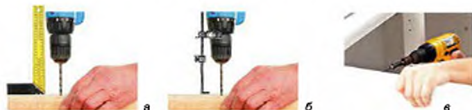
Мал. 130. Свердління електродрилем: а – контроль перпендикулярності свердління; б – свердління отвору з обмежувачем; в – загвинчування шурупів
