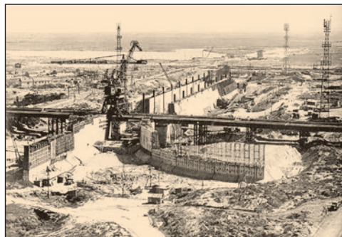
Будівництво Каховської ГЕС. 1953 р.
