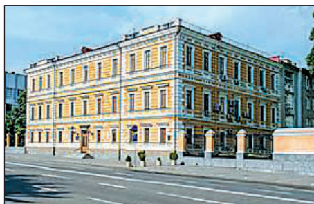
Будівля Президії НАН України
