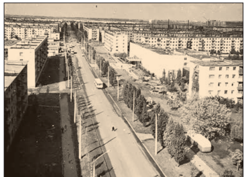
Мікрорайон, забудований «хрущовками»
