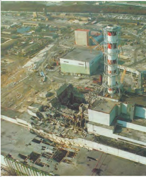
↑ Зруйнований четвертий реактор ЧАЕС
