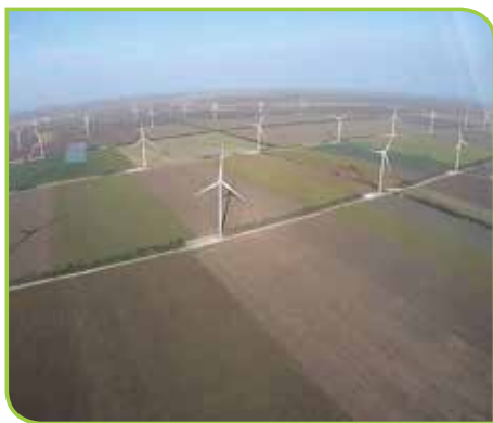
Ботіївська вітрова електростанція
