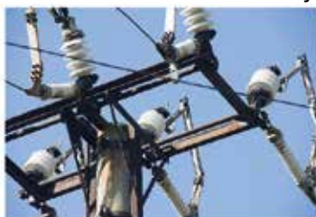
На лініях електропередач використовують порцелянові й скляні електроізолятори
