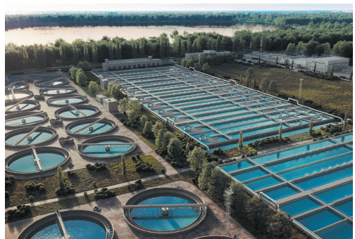
Станція для очищення стічних вод
